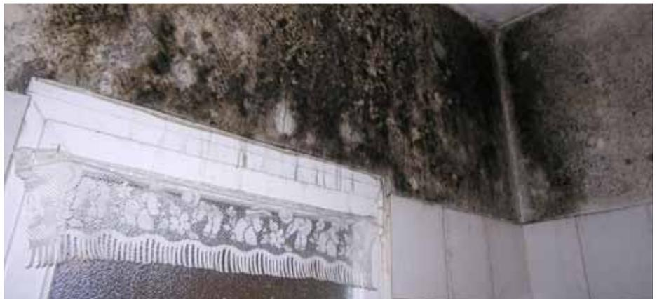
L'un des problèmes les plus récurrents à Bischheim concerne l'humidité causée le plus souvent par une ventilation insuffisante du logement associée à un défaut de chauffage. Cela fait souvent suite à l'installation d'huisseries étanches sans dimensionnement correct de la ventilation.
